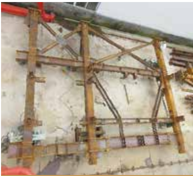
屋外仮組ヤード 68m(L)×12m(W)×11m(H)
