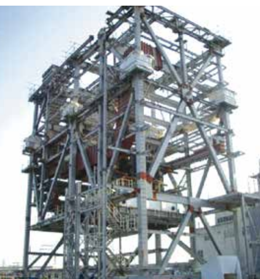
ボイラー鉄骨
