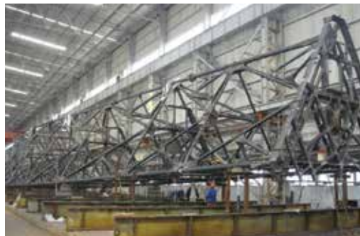
スタック架構 全体仮組 全長80M
