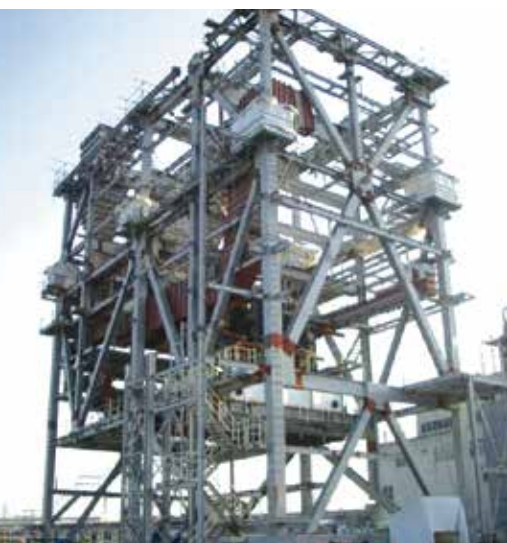
ボイラー鉄骨
