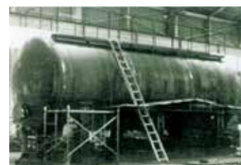
油計量タンク
